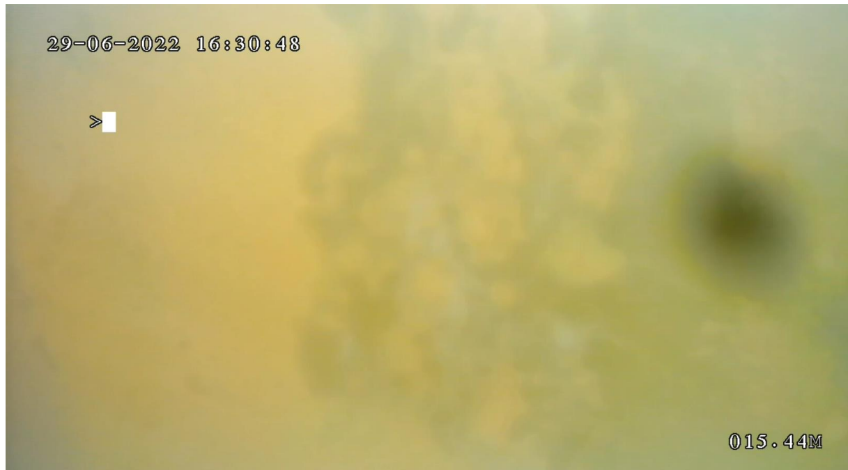
Photographie 4 : Différence de recouvrement du tubage observée à 15,44 m/repère
