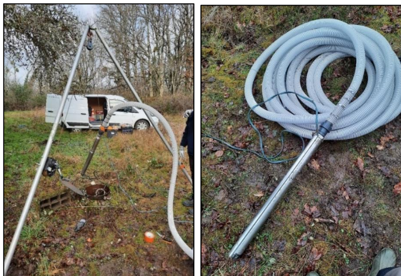
Figure 19 - Matériel utilisé pour l'essai de pompage
